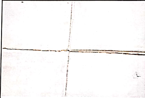
Foto 4: Sustitucion de Azulejo
