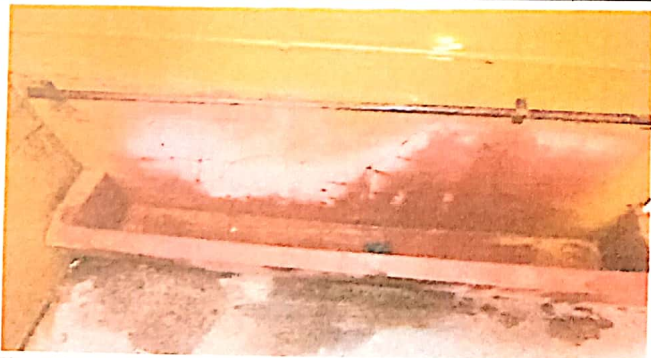
Foto 5: Colocación de Azulejo
