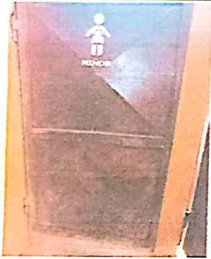
Foto 3: Puertas servicios sanitarios
