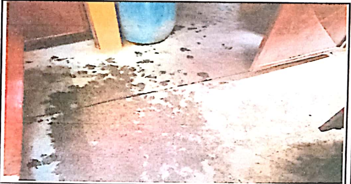
Foto 6: Sustitucion de piso
